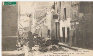
Photo des dégâts après le séisme en 1909 >
